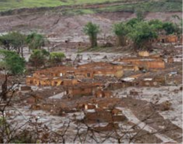
Queda da barragem matou 19 pessoas em Minas
