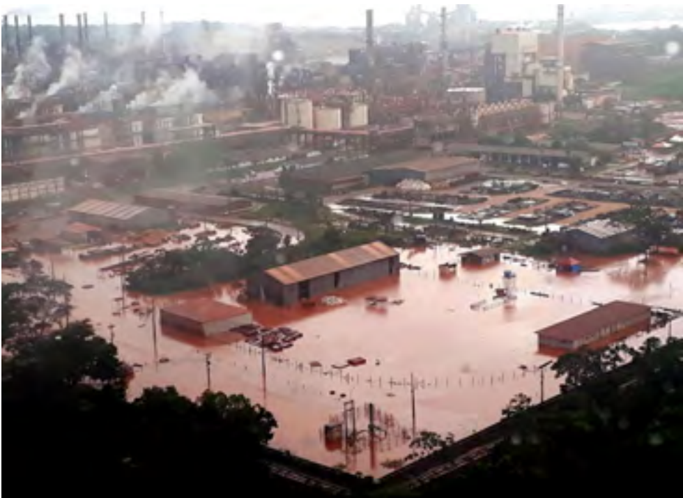
Vazamento inundou a região de Barcarena, inclusive a sede da multinacional
