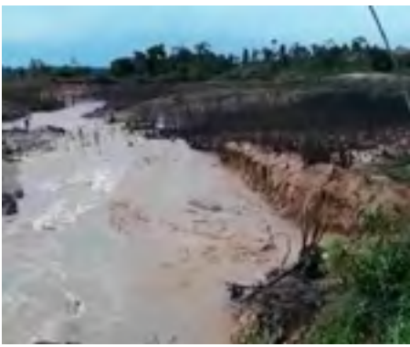
MP-RO investiga o rompimento
