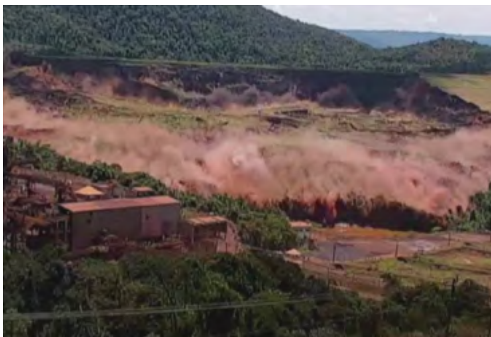
Rompimento da barragem da Vale em Brumadinho causou a morte de 270 pessoas e a destruição do leito do Rio Paraopeba, em Minas Gerais
