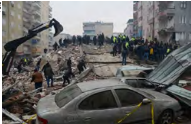
Prédio destruído na região sudeste da Turquia
