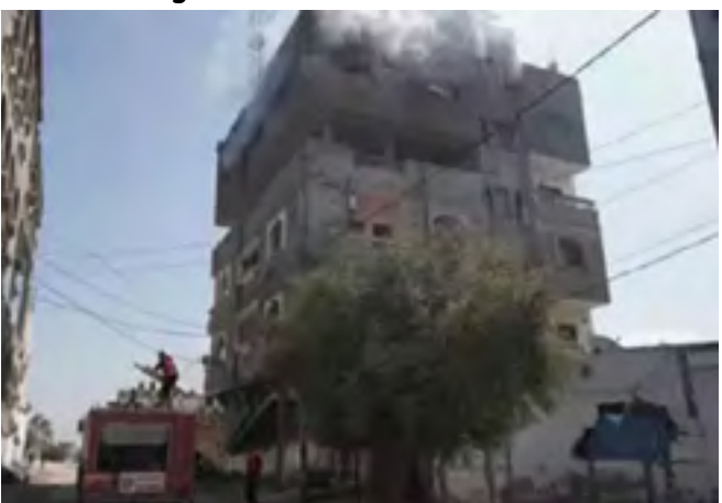
Prédio em chamas após ataque com bombas israelenses na cidade de Nusseirat, centro de Gaza
