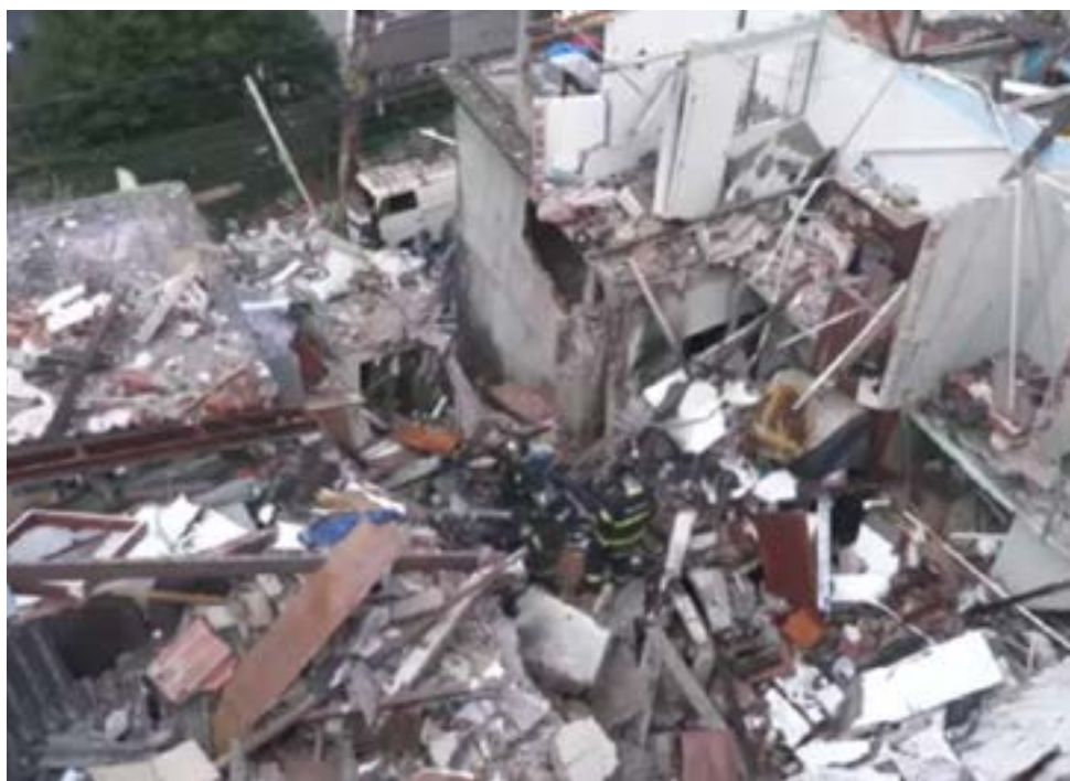
Explosão causada por obra da Sabesp no bairro do Jaguaré matou 2 pessoas
